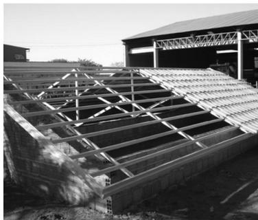
**Figuras 3 e 4** – posicionamento de cobertura metálica e cobertura metálica com telhamento.
