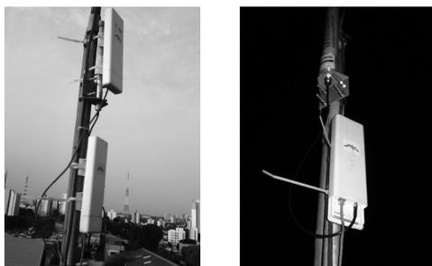
**Figura 2** – (a) instalação encontrada ao detectar os problemas, rádios se interferindo; (b) nova instalação de antena e separação física dos rádios
