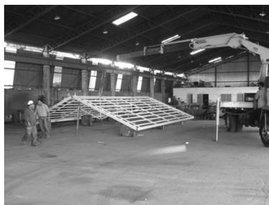
**Figuras 1 e 2** – fabricação de cobertura metálica e içamento de cobertura metálica.
